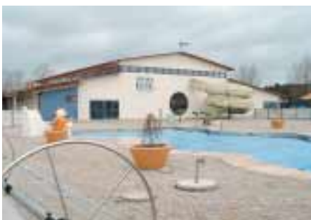
Utomhuspoolen värms upp av badhusets effektiva värmeåtervinningssystem och kan därmed hållas öppet två månader längre än normalt.
